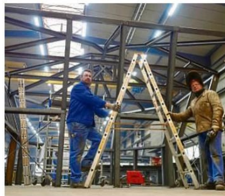
Freuen sich über einen besonderen Auftrag: Mitarbeiter der Firma Stahlbau Ebert bei der Arbeit.
