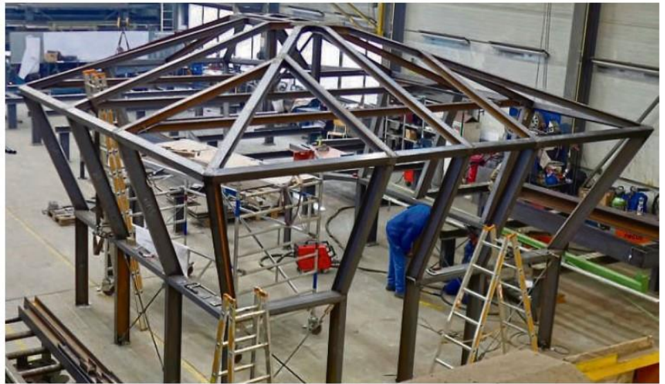
Wie das Original: Der Nachbau steht noch in den Hallen der Firma Stahlbau Ebert in Hanau. Bisher wurde er nur gehaftet, verschweißt wird die Konstruktion vor Ort.
